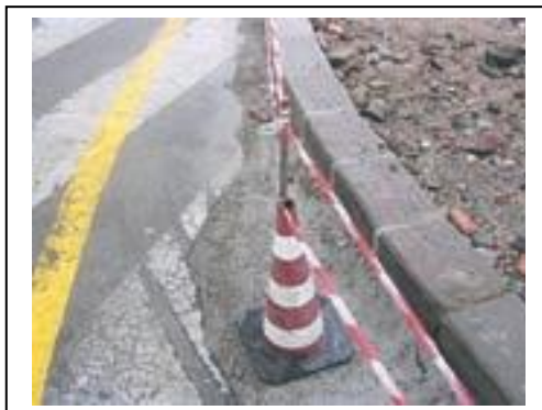
Situazione non regolare, il ferro sporgente dal cono non è protetto
